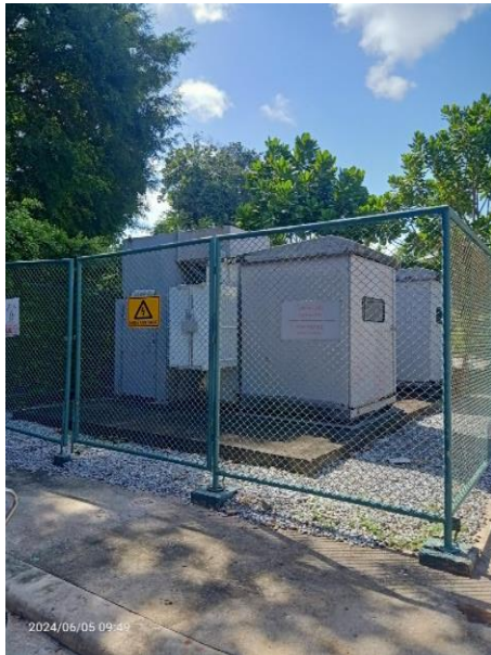
ภาพที่ 21 แสดงหม้อแปลงไฟฟ้า
